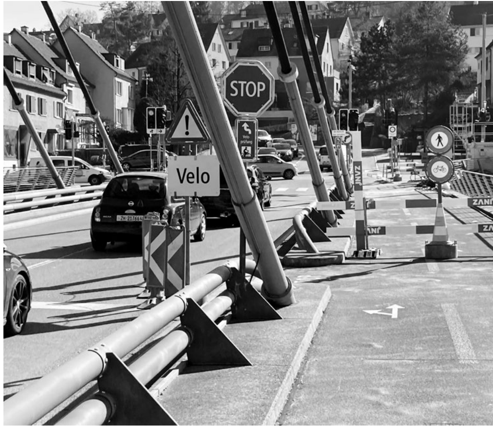
Top: sauber signalisierte Einfädelung für die Velos vor dem Baustellenbereich.
