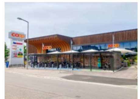
Der Bordstein vor dem Grüzemarkt wurde endlich abgesenkt.
